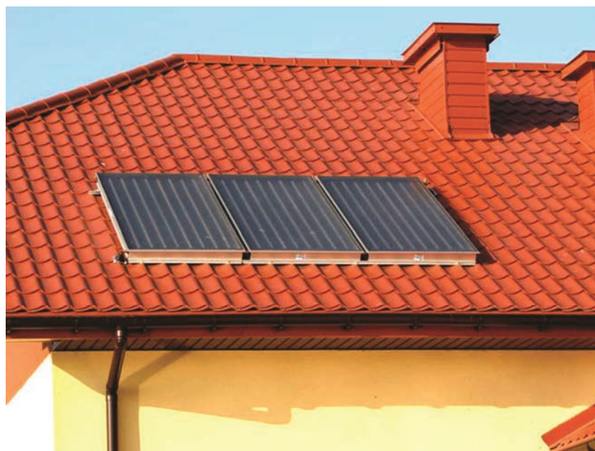
Kolektory słoneczne na budynku remizy OSP we wsi Mchowo w pow. przasnyskim zainstalowane w ramach projektu zrealizowanego przez Gminę Przasnysz.
