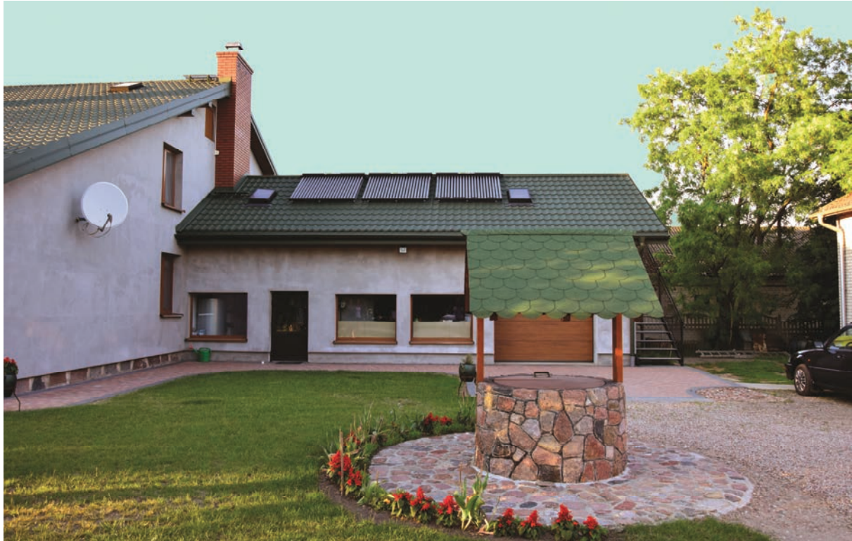
Kolektory słoneczne zainstalowane na budynku mieszkalnym w gospodarstwie rolnym w miejscowości Bartolty w gm. Krasne.
